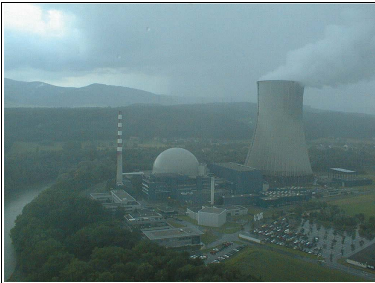
Das Kernkraftwerk Gösgen (KKG) aus der Luft.
